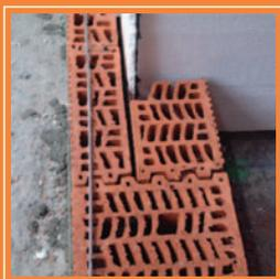
Colocar la plaqueta Termoarcilla de 9,6 cm para el recubrimiento exterior de los pilares.
