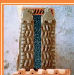
Opcionalmente, si queremos aumentar el aislamiento térmico, podemos colocar una banda de un material aislante flexible en la junta interrumpida del tendel.
