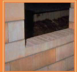
En general, no utilizar material diferente al bloque Termoarcilla para nivelar. No obstante podrá utilizarse ladrillo perforado, con resistencia a compresión igual o superior a la del bloque Termoarcilla, en aquellos tramos de muro situados en zonas no habitables.
