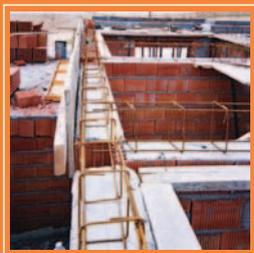
El apoyo del forjado puede hacerse sobre los bloques Termoarcilla o sobre la pieza de dintel cortada en L.
