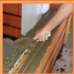
Cuando el tendel se ejecute con dos bandas de mortero, usar la regla a modo de guía para enrasar el mortero.
