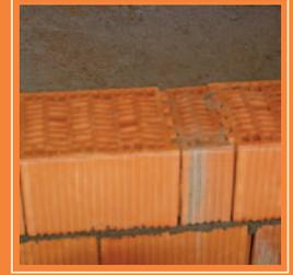
La junta vertical entre pieza base y pieza cortada se realizará mediante cordones de mortero (máximo dos juntas por tramo).
