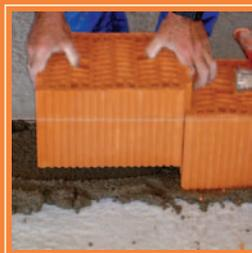
Colocar los bloques verticalmente, no a restregón, haciendo tope con los machihembrados.
