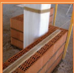
*NOTA: En muros exteriores en los que sea necesaria la mejora de las prestaciones mecánicas o acústicas, se puede considerar su ejecución con junta continua, salvo en aquellos muros sometidos a condiciones climáticas o de exposición desfavorables.*
