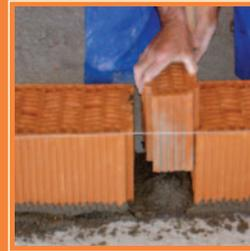
En ningún caso se realizarán ajustes horizontales abriendo las juntas verticales, utilizando otros materiales distintos a Termoarcilla, o colocando rellenos de mortero de gran espesor.
