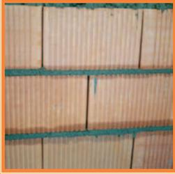
**M**antener una separación mayor o igual de 7 cm entre juntas verticales de hiladas consecutivas, para obtener la traba de la fábrica.
